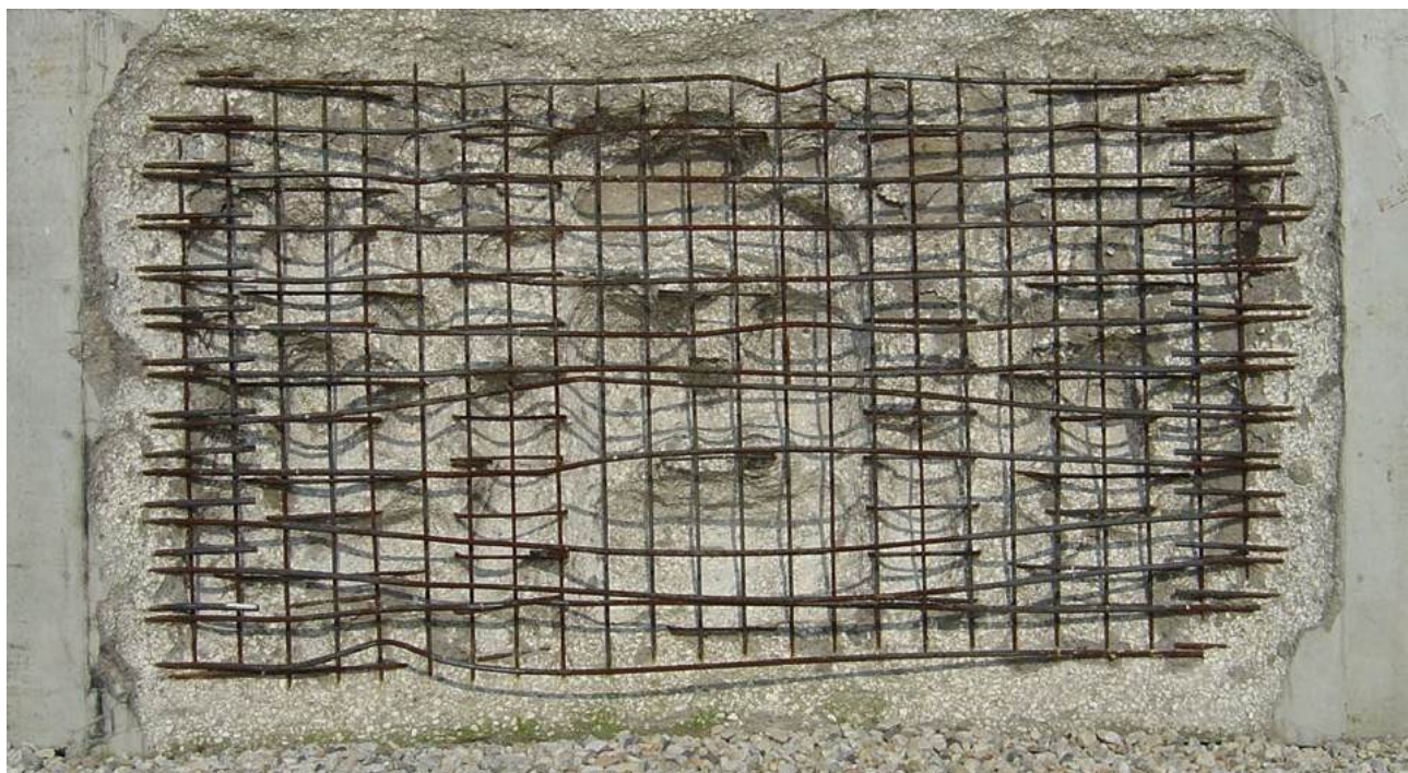
コンクリートが急速に加熱され、高い熱応力が発生した場合、コンクリート構造要素にかなりの損傷が生じる可能性がある。
